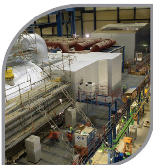
Piping of HRSG No. 12 ,11
