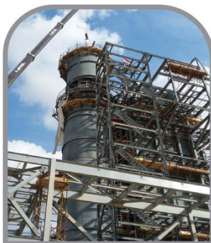
Full erection For 4 HRSG (Mechanical & Piping)
