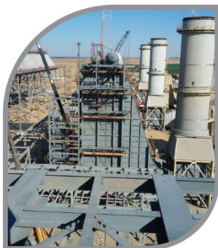
Full erection For 4 HRSG (Mechanical & Piping)
